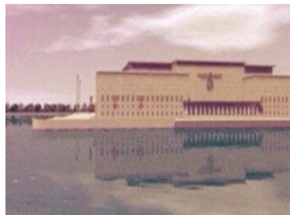
Quelle: DVD; Doku-Zentrum Nürnberg
