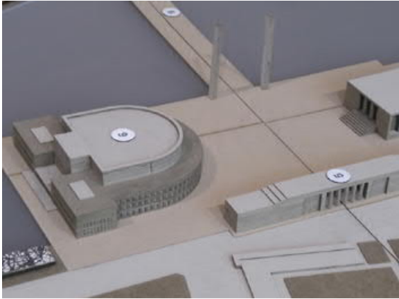
Die geplante „Kongresshalle“ wieder mit dem „falschen“ Flachdach. Final sollte das Dach aus statischen Gründen eine Neigung nach oben bekommen © Rekonquista
